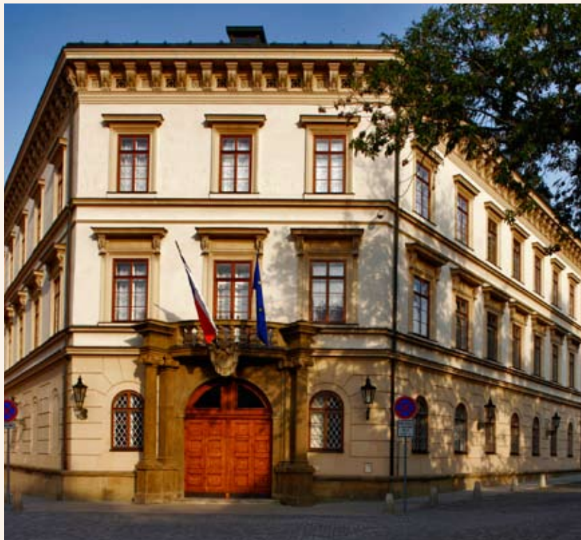
Západní průčelí paláce se vstupním portálem
