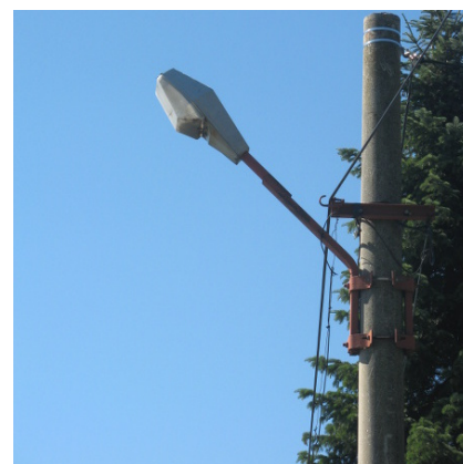
Obrázek 25: Takto NE: Nemělo by docházet k situacím, kdy je svítidlo nakloněné pod úhlem 45^\circ nebo i více. Takový náklon v žádném případě nezajistí lepší osvětlení, ale pouze vyšší světelné znečištění. Téměř vždy takové svítidlo oslňuje. Jedná se o jeden z nejčastějších nešvarů osvětlení zejména na venkově.
