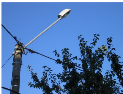
Obrázek 25: Takto NE: Nemělo by docházet k situacím, kdy je svítidlo nakloněné pod úhlem 45^\circ nebo i více. Takový náklon v žádném případě nezajistí lepší osvětlení, ale pouze vyšší světelné znečištění. Téměř vždy takové svítidlo oslňuje. Jedná se o jeden z nejčastějších nešvarů osvětlení zejména na venkově.
