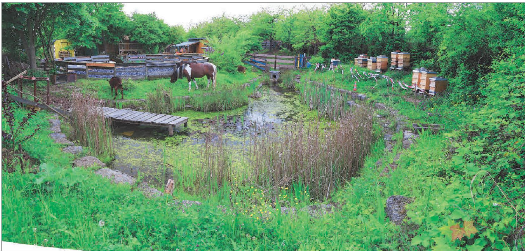
Posledním objektem na odvodnění v ul. Blaumeisenweg je retenční nádrži venkovského charakteru (foto Ing. J. Vitek, 05/2014)
