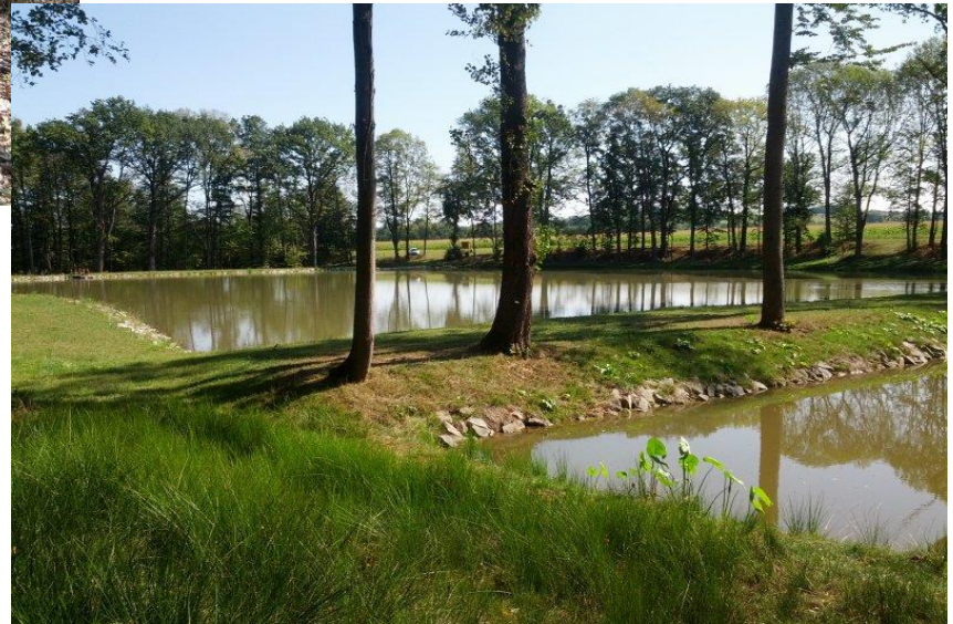
stav po realizaci k.ú. Třanovice (multifunkční prvek doplňující systém rybníků s vodohospodářskou, ekologickou a krajinotvornou funkcí)
