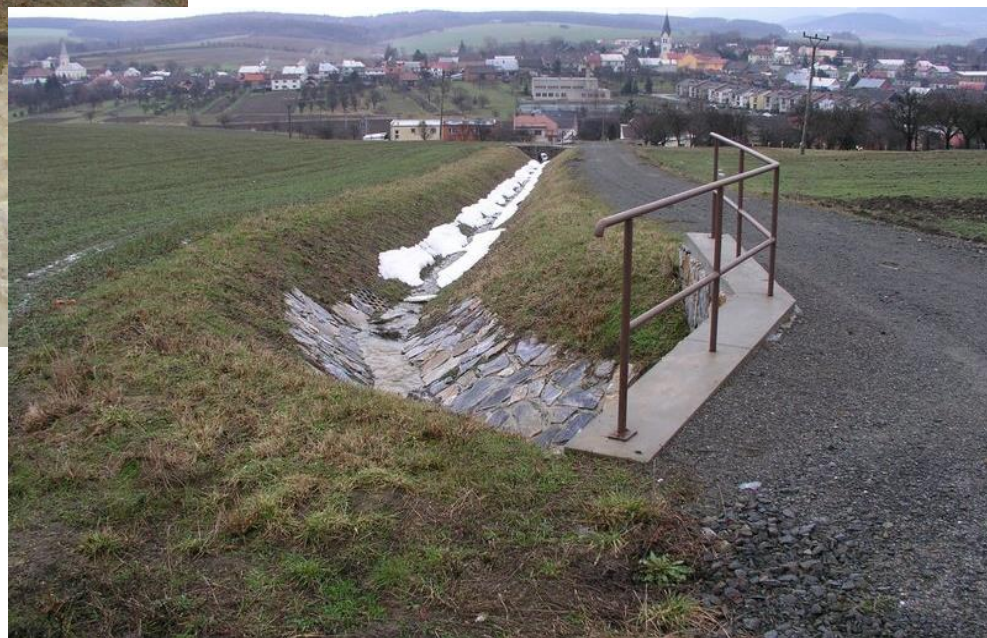
stav po realizaci k.ú. Prusinovice (svodný příkop s opevněním)
